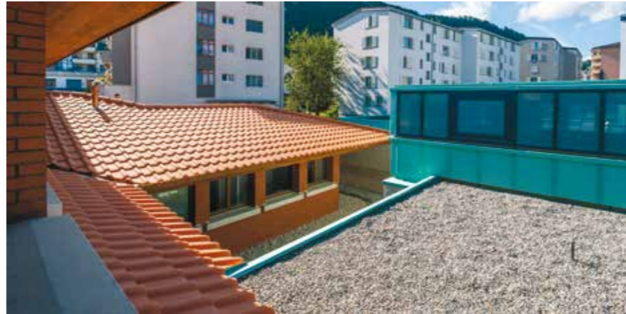
Die Vielseitigkeit der Krauer GmbH in einem Bild zusammengefasst: Flachdacharbeiten, Spenglerarbeiten und Ziegeldeckung
